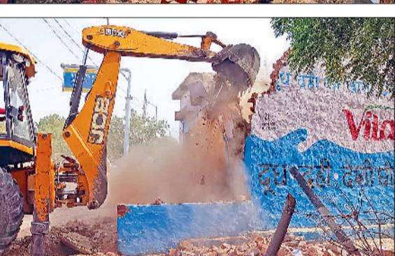
बवानीखेड़ा। अवैध निर्माण को तोड़ती जेसीबी मशीन। फोटो: हरिभूमि
